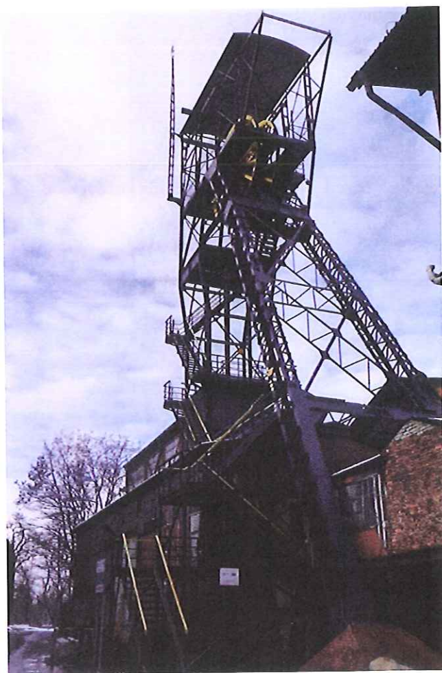
Rys. 13. Wieża szybu „Carnall”, stan z roku 2011 (zdjęcie: M. Głosz)
