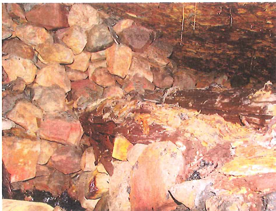
Rys. 5. Komora dawnego portu załadunkowego – stan z 2011 roku (zdjęcie: T. Bugaj)
