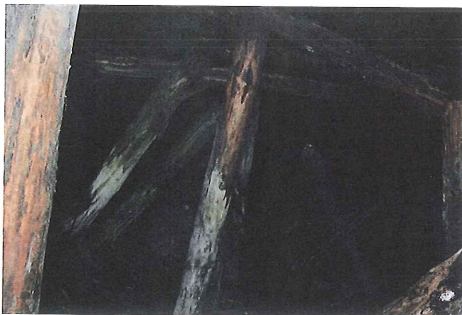
Rys. 10. Drewniana obudowa w chodniku z XIX wieku, stan z roku 2011 (zdjęcie: M. Glosz)
