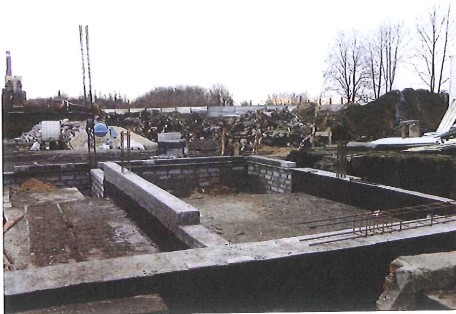
Rys. 12. Plac budowy przy ul. Sienkiewicza w Zabrze, stan z roku 2011 (zdjęcie: M. Głosz)
